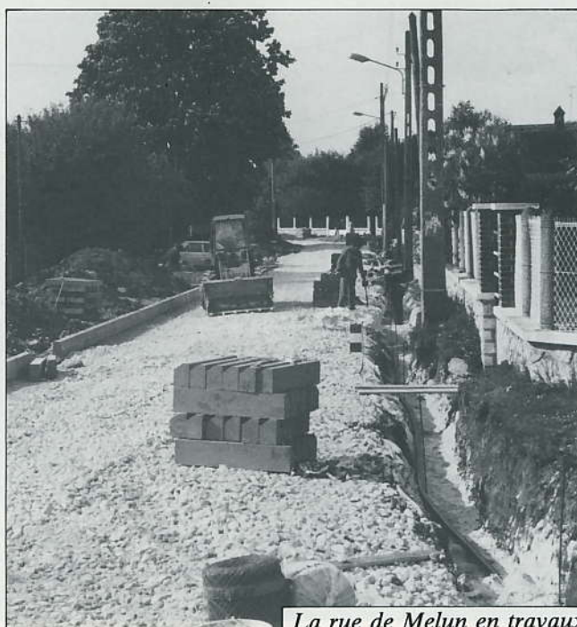
La rue de Melun en travaux
