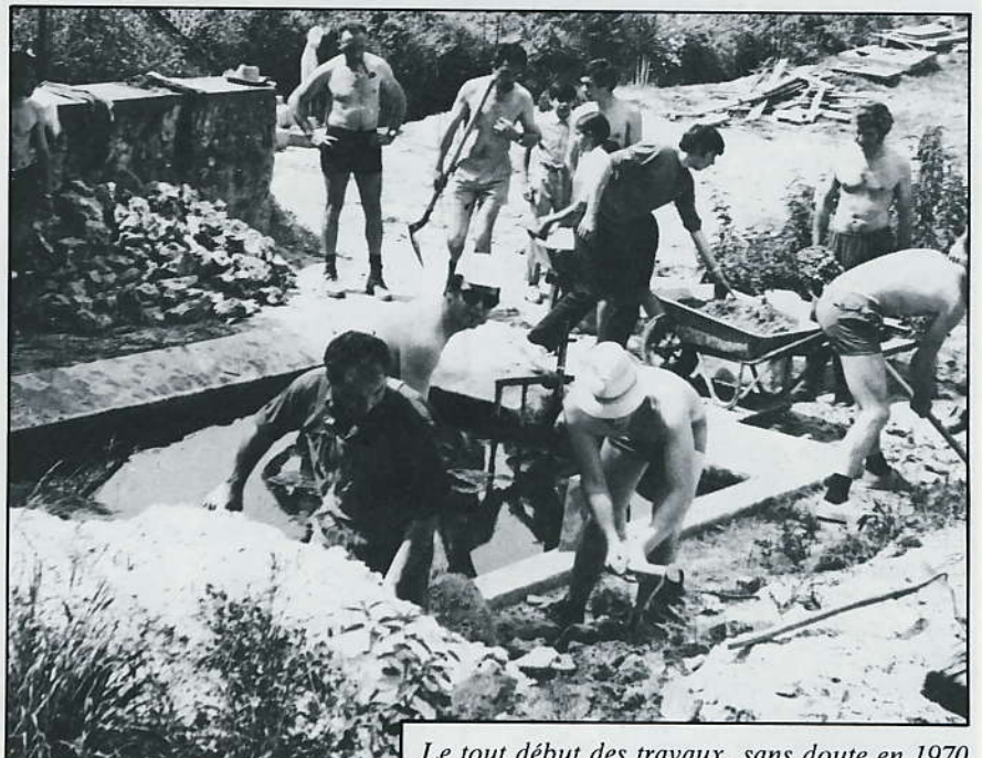
Le tout début des travaux, sans doute en 1970
