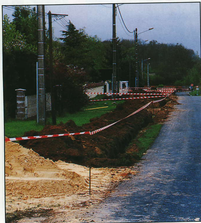
Adduction du gaz dans la partie basse du chemin latéral
