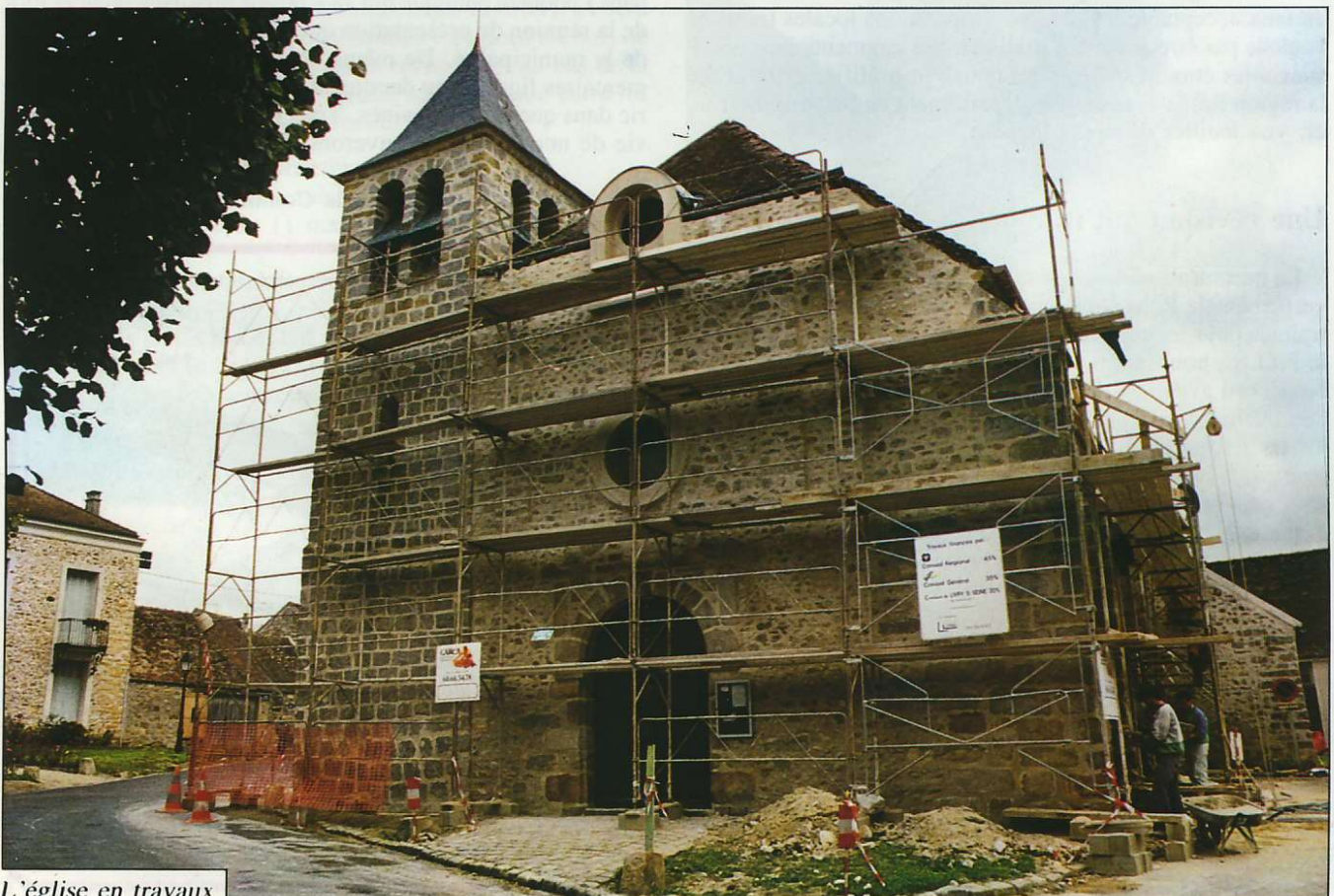
L'église en travaux
