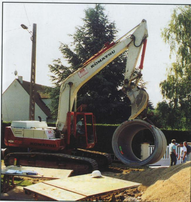
*D'énormes buses de près de 2 mètres de diamètre ont été enterrées pour réaliser la chambre de retenue de 45 mètres cubes au débouché de la rue des Mardelles sur la rue du Four-à-Chaux.*
