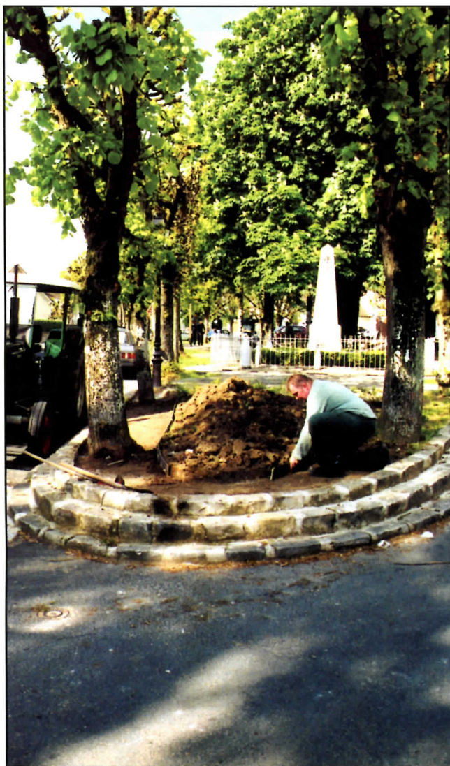
Réalisation d'un massif près du monument aux morts.
