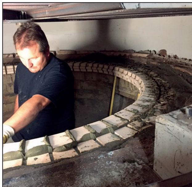
Il a fallu près de deux semaines de travaux par une entreprise spécialisée pour refaire l'intérieur du four à bois de notre boulangerie. Mais il en valait bien la peine ...
