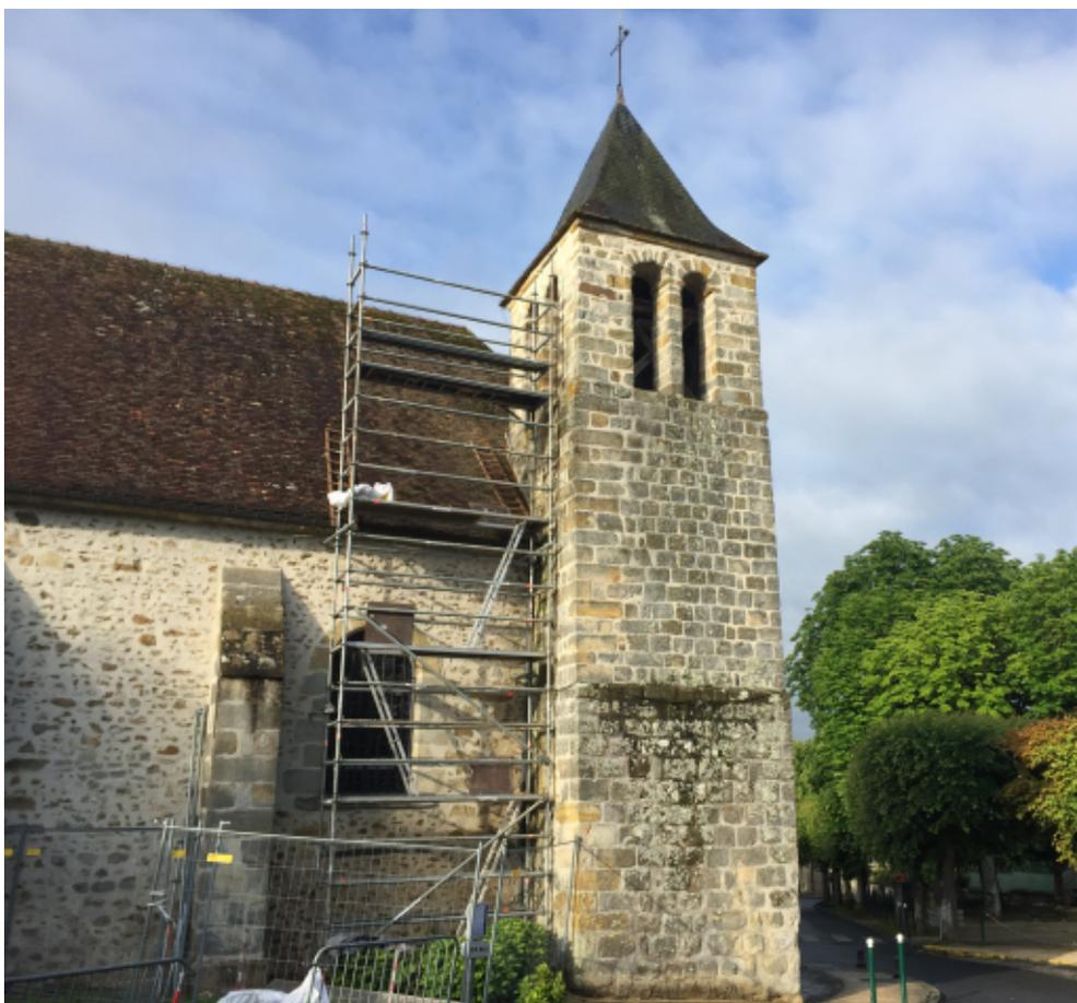
*1ère phase de restauration de l'église : des travaux urgents s'imposent sur la toiture, en effet des soudures défectueuses dans le chéneau ont provoqué des infiltrations d'eau conséquentes à l'intérieur de l'édifice créant des détériorations et fragilisant le plafond. D'autres travaux sont à envisager sur l'entretien de la toiture mais restent à ce jour à l'étude : demande de devis, visite d'un expert et recherche de financement.*
